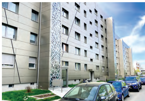
Auch so kann WBS 70 aussehen: frisch sanierte und gestaltete Fassaden mit vorgesetzten Fahrstuhlambauten
