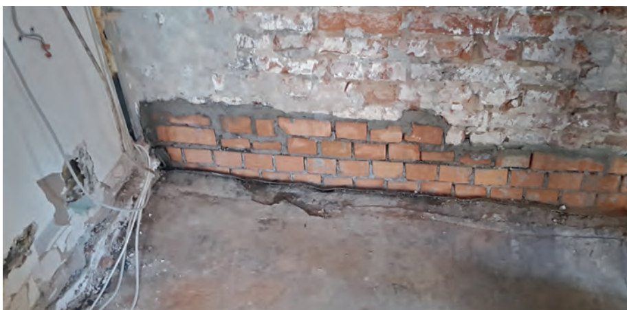
Bauvorhaben Königsbrücker Straße 37, Dresden
