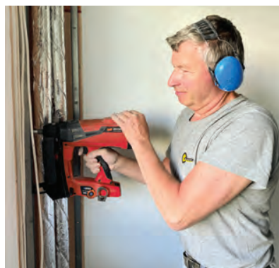
Uwe Matthes beim Montagearbeiten der neuen Heizungsrohrkanäle
