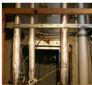
Blick in einen Heizungsschacht
