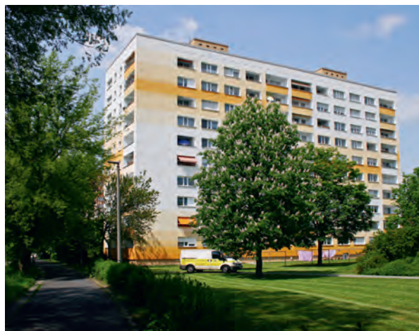
Bereits fertiggestellt ist die Fassade der Breiten Straße 3 a-c
