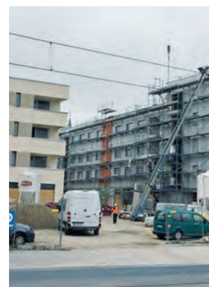
Bauvorhaben Markus-Passage in Dresden-Pieschen
