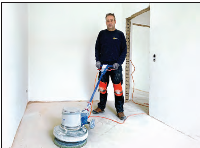
Vorbereitung für die Verlegearbeiten des neuen PVC-Belages
