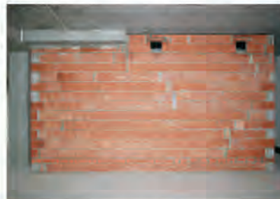
Hinter der Wand verbirgt sich ein isolierter Pfeiler des Hochgleistragwerks.
