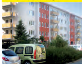
... und nach den umfangreichen Sanierungsarbeiten
