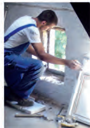
620 Fenster und 558 Türen wurden demontiert, entsorgt und neue eingebaut.
