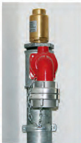
Endstück einer Steigleitung für Löschwasser
