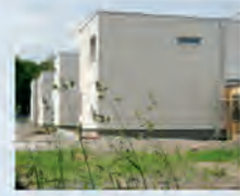
Gerade fertig geworden sind Wärmeschutz- und Fassadenarbeiten.
