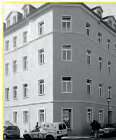
Eine etwas heikle Arbeit, die sich gelohnt hat – Vollwärmeschutz für das Haus Vorwerkstraße 1
