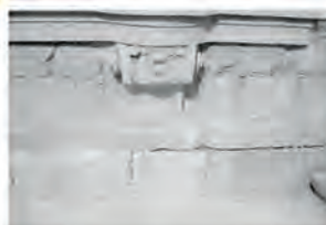
Behebung von Hochwasserschäden am Sandsteinsockel der historischen Fassade
