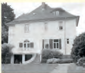
Terrasse nach der Sanierung
