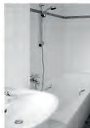
Bad nach der Sanierung
