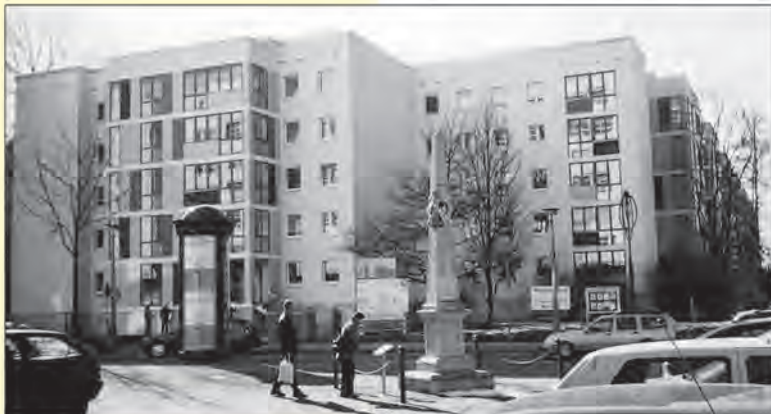
Modern gestaltete Anbauten lockern die Fassaden auf. Die eingebauten Fahrstühle erhöhen den Wohnkomfort.
