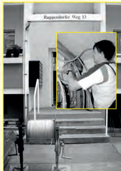
Für die WG „Aufbau“ werden 43 WBS-70 Hauseingänge in Dresden-Gruna mit neuen Elektroanlagen ausgestattet
