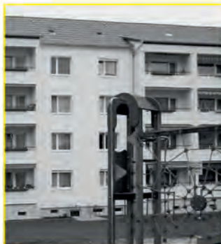
Auftraggeber: Eisenbahnerwohnungs-genossenschaft; Bauvorhaben: Steinbacher Straße 5-11; Leistung: Vollwärmeschutzsystem
