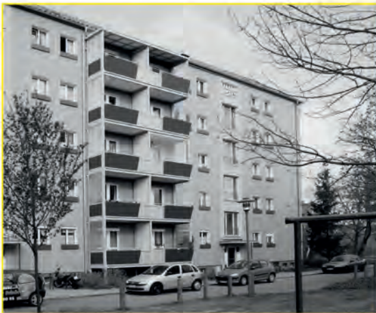
Auftraggeber: WG Johannstadt; Bauvorhaben: Schandauer Str. 1-23; Leistung: Vollwärmeschutzsystem
