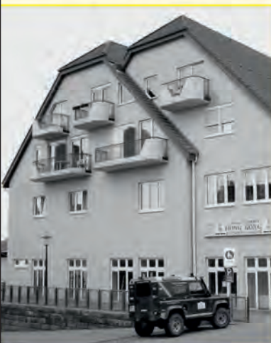
Auftraggeber: Mietplan GmbH; Bauvorhaben: Potschappler Straße 4, Dresden; Leistung: Wartungsarbeiten Fenster/Türen
