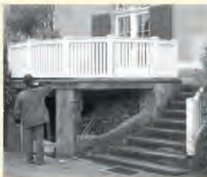
Terrasse vor der Sanierung
