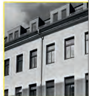
Auftraggeber: Architekt Dr. Konow; Bauvorhaben: Prießnitzstraße 49, Dresden; Leistung: Dachheizzentrale mit Brennwertkessel, wandhängend
