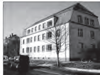
Gartenhainsiedlung in Dresden-Gruna, Erneuerung der elektrischen Installationen
