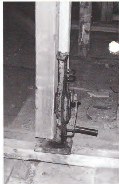
Schrittweise angehoben, wird der Dachstuhl untermauert.
