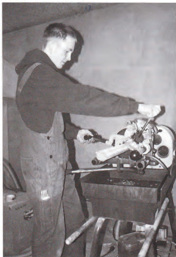
Gewindeschneiden ist eine hohe Kunst... einer unserer Sanitärlehrlinge bei der konzentrierten Arbeit
