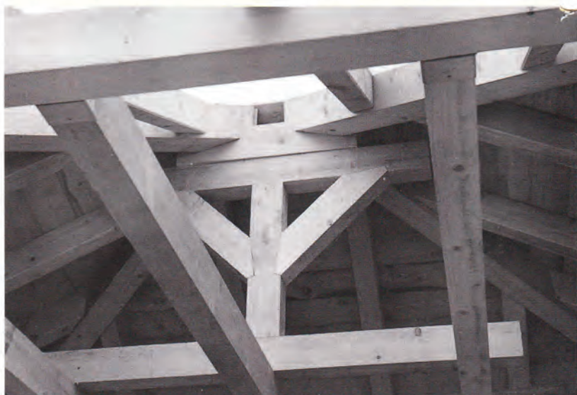
Das muß halten: Verbindungen in einem Dachstuhl.
