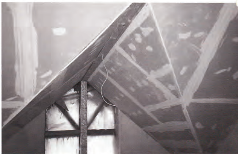
Anspruchsvoll: Sichtbare Giebelkonstruktionen im Verbund.
