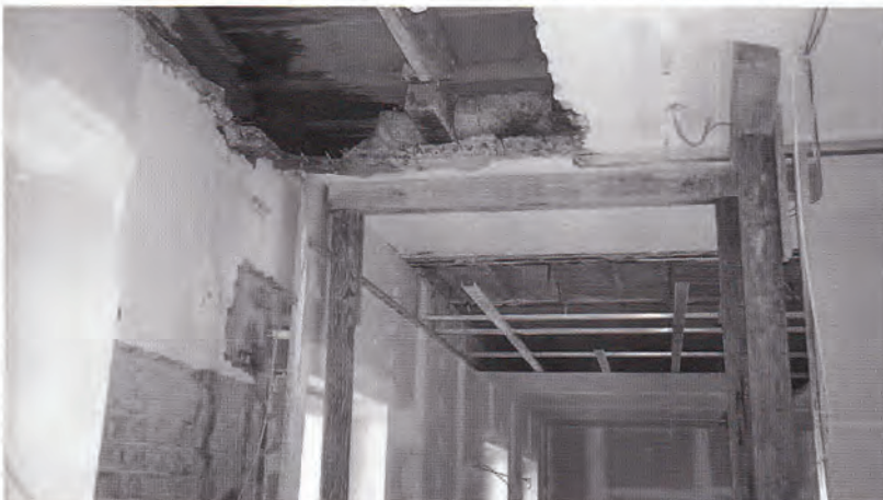
Die schnelle Weiterverarbeitung der gestellten Flächen ist einer der wesentlichen Vorteile des Trockenbaus.
