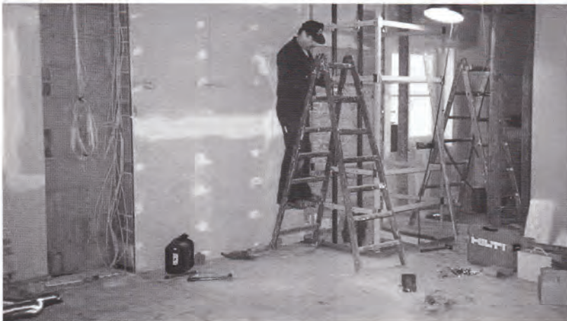
Komplexsanierungen gehören zu den gängigen Trockenbau-Aufträgen.
