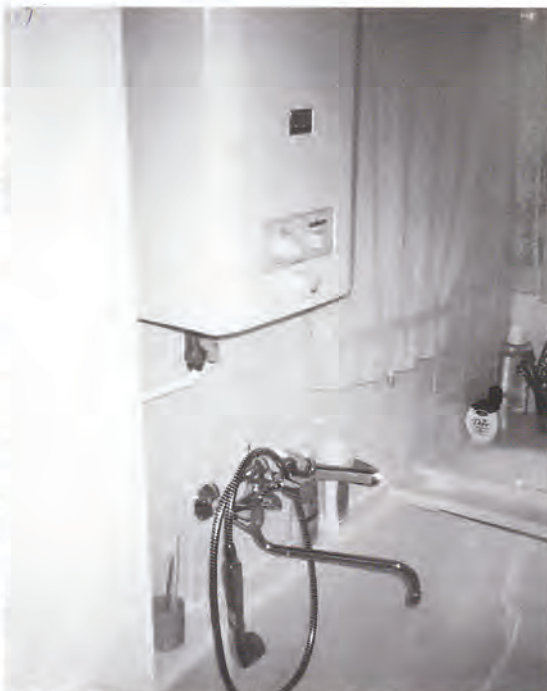
Ein Bad nach der Sanierung: mit der Heizungsumstellung 1999 wird der Gasdurchlauferhitzer auch noch verschwinden.
