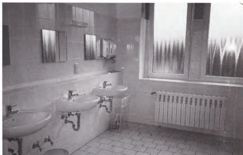
Reibungslose Sanierungsarbeiten setzen ein großes Maß an Organisation voraus.
